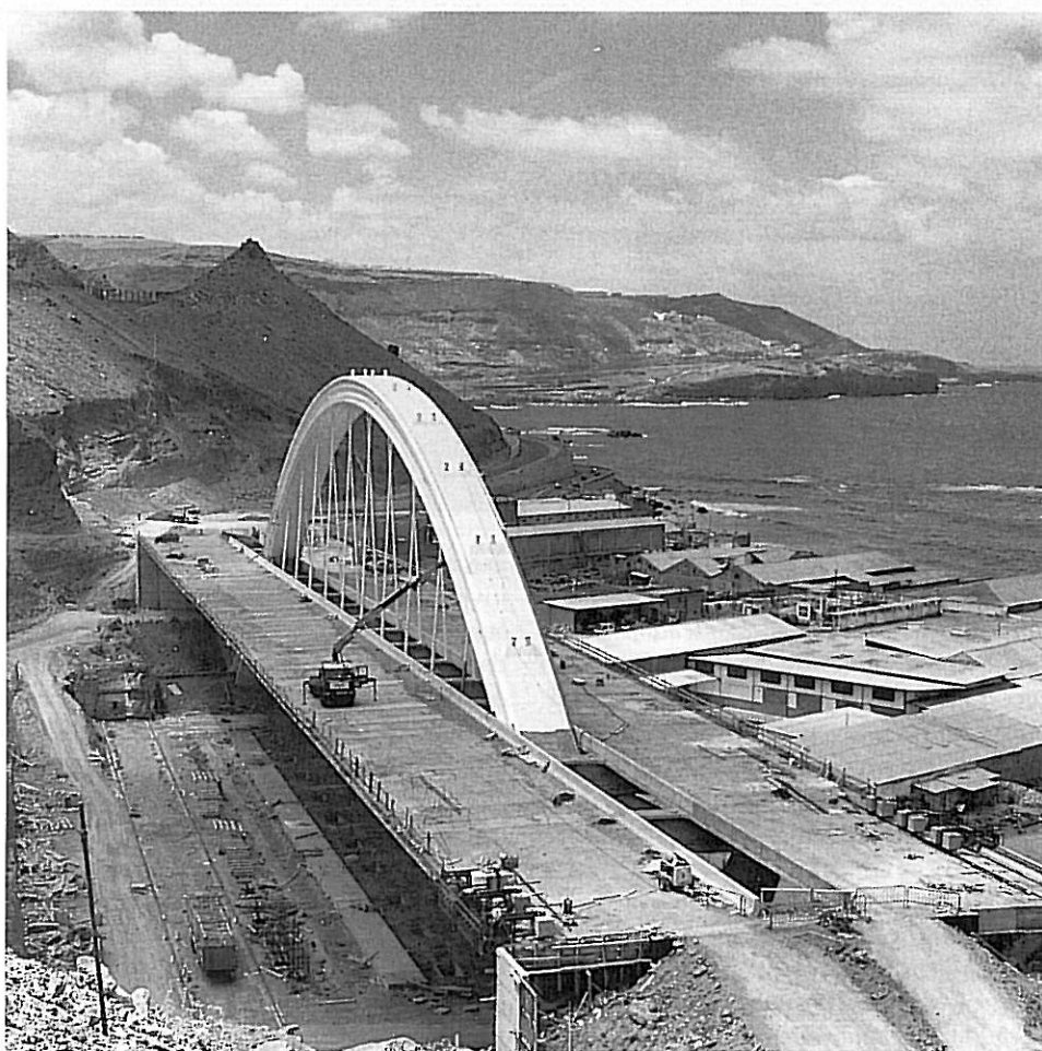
... 30. Completato il fissaggio dei conci ai cavi di sostegno si è proceduto con il getto dei giunti trasversali di completamento e di solidarizzazione dell'intero impalcato; 31. Particolare della struttura trasversale del concio su cui si attestano i doppi ancoraggi dei sostegni; 32. Intradosso dell'impalcato a doppia struttura collegata da setti trasversali su cui si innestano i cavi metallici di sostegno.
