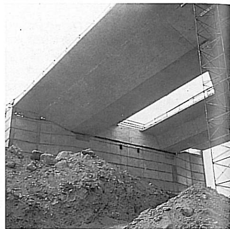
... 13. Tratto di impalcato in prossimità della spalla sorretto dal pilone a forma di «V» realizzato mediante getto in opera; 14. Il cantiere con in evidenza il tratto di impalcato compreso tra la spalla e l'imposta dell'arco; 15. Intradosso dell'impalcato in corrispondenza della spalla; 16. Assemblaggio dell'armatura nel tratto di impalcato del lato opposto; 17-18. Strutture di sostegno per l'esecuzione del getto di alcuni tratti di impalcato; 19. La sezione dell'impalcato caratterizzata dalle larghe ali che alleggeriscono l'impatto visivo della struttura; 20. Gli appoggi a terra dell'opera tutti localizzati alle estremità.
