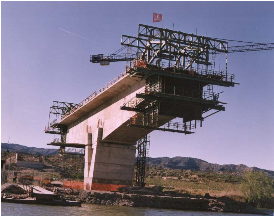
Figura 4. Voladizo de P1 en construcción
