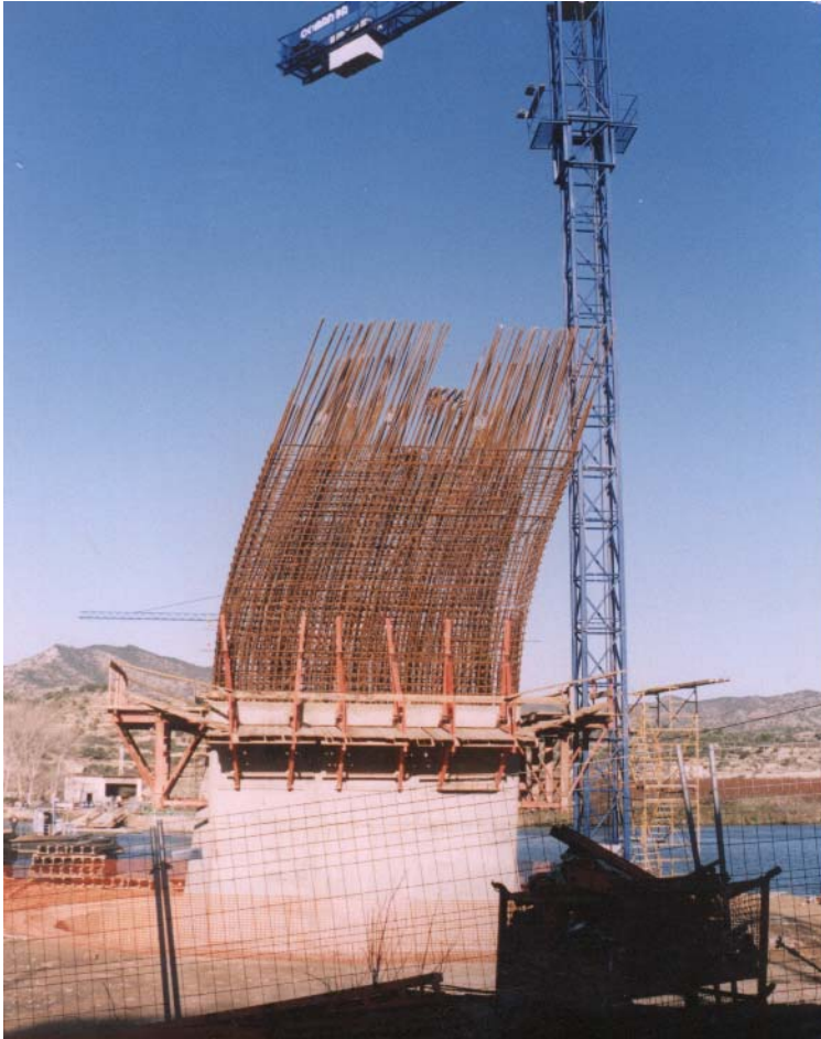
Figura 6. Pila P2 en construcción
