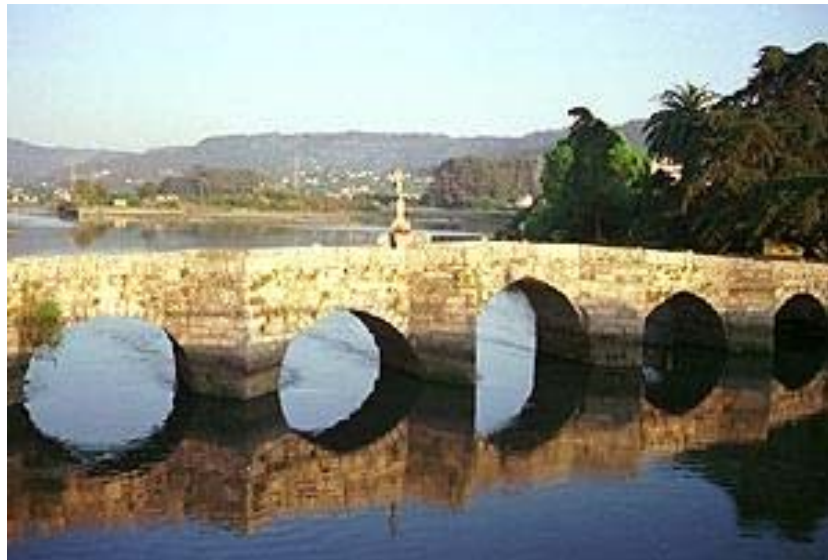
Foto 14: Tímpano macizo del Puente de A Ramallosa
