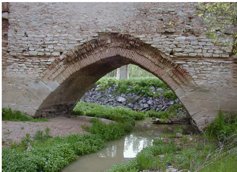
Foto 12: Triple rosca en bóveda de ladrillo del Puente de Arevalillo
