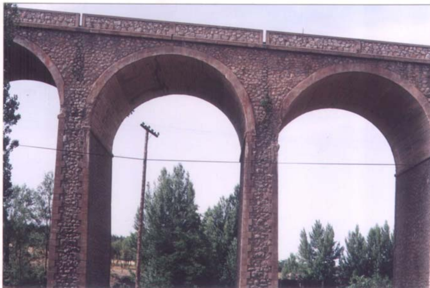
Foto 6: Pilas modernas del Puente sobre el arroyo de Valdelobos
