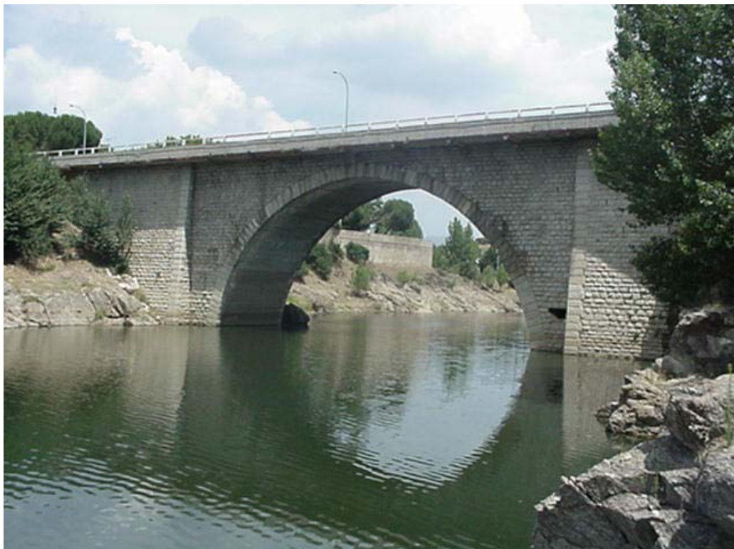
Foto 3: Estribos de sillería del Puente sobre el río Lozoya
