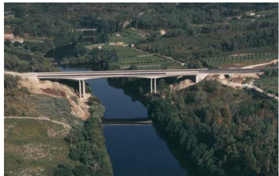
Foto 2: Puente sobre el río Ulla
