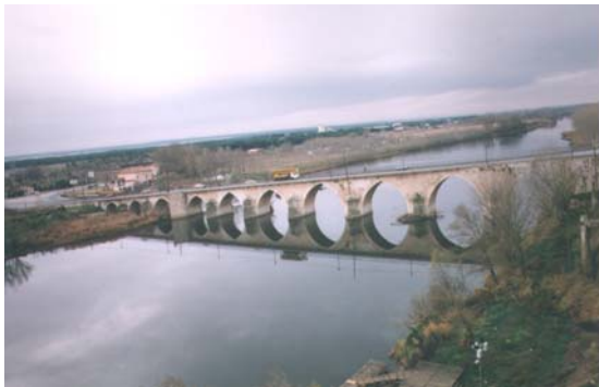
Foto 1: Puente de Tordesillas
