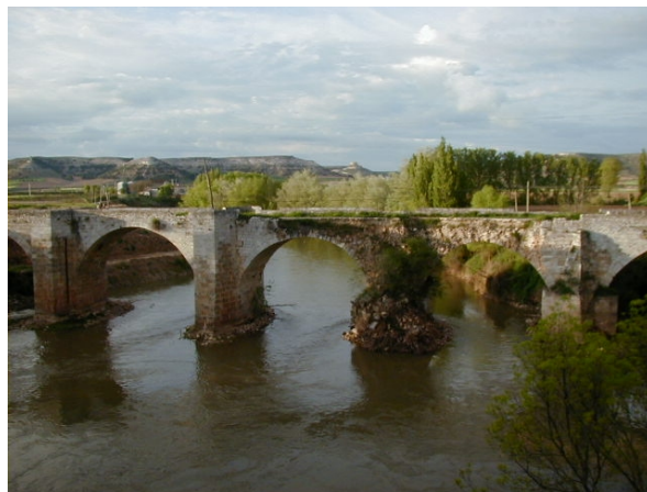
Foto 16: Relleno del Puente de Pesquera
