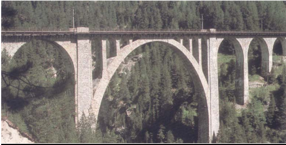
Foto 15: Tímpano aligerado del Puente de Abbassabad (Turquía)
