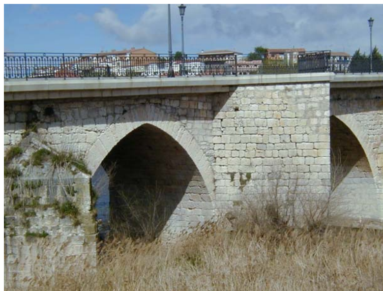
Foto 10: Bóveda ojival del puente de Tordesillas
