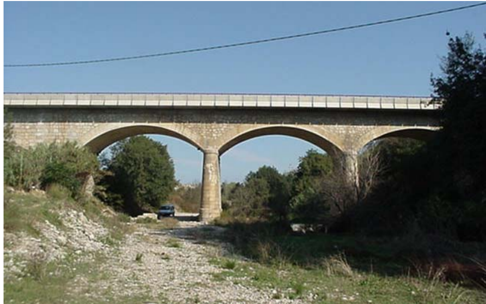
Foto 9: Bóveda escarzana del Puente sobre el río Manol
