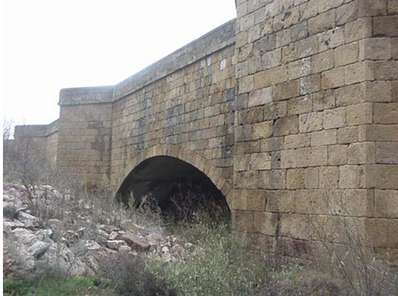
Foto 5: Pilas medievales del Puente del Paso Honroso sobre el río Esla
