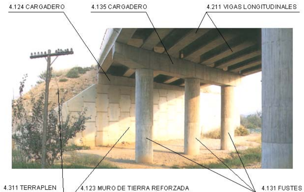
Figura 2. Elementos del puente
