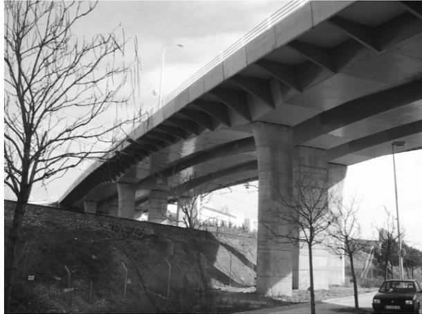
Las pilas son de hormigón armado, formadas por prismas 2 x 1 m, una bajo cada cajón. Los fustes exteriores tienen su cara externa redondeada. En la zona de coronación del fuste, en su encuentro con el tablero, se produce un ensanchamiento del prisma definido, con radio de curvatura de 12,75 m. La cimentación es directa en pilas 3, 4 y 5, mientras que es profunda, sobre pilotes, en pilas P1 y P2 y en ambos estribos.
