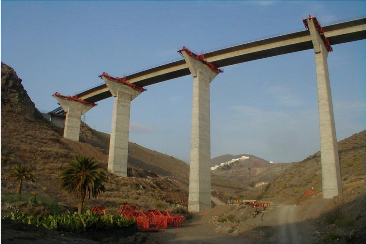
La combinación de pila única con el sistema constructivo de empuje utilizado para los tableros, creemos que es una novedad. En España no hay ningún precedente ya que se han realizado tipologías similares pero utilizando autocimbras.
