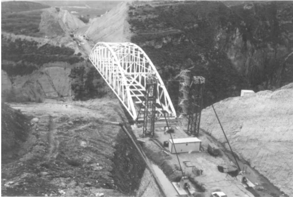
Viaducto al final del lanzamiento.
