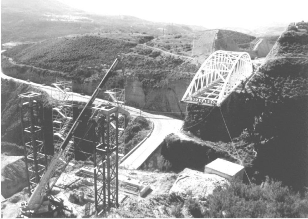
Lanzamiento del puente: vista de torres y vientos.
