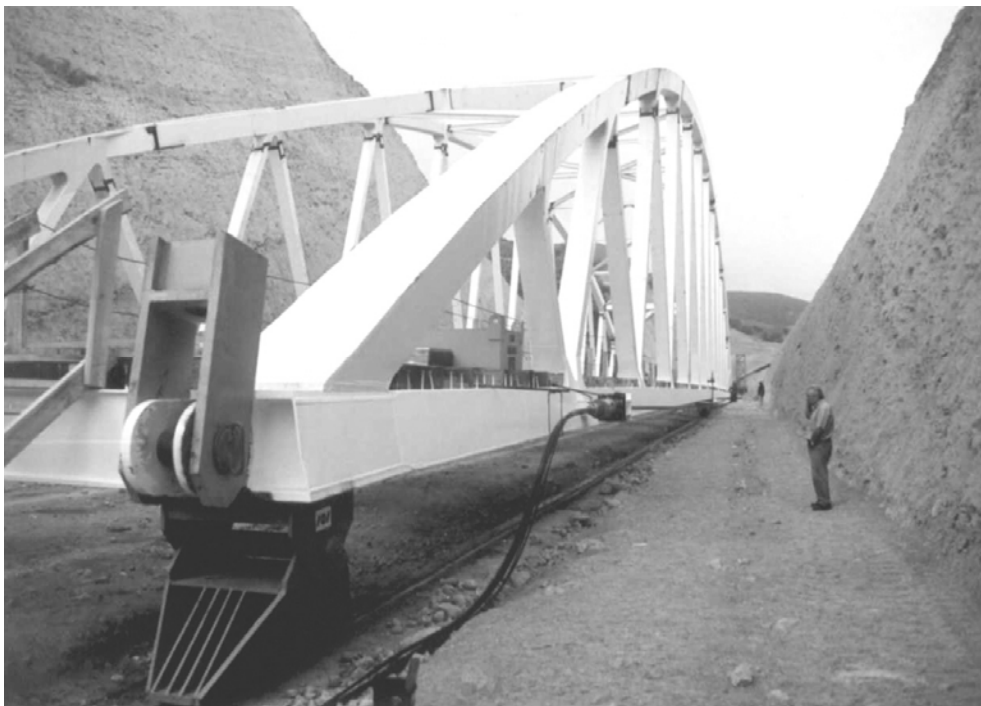
Puente sobre los carriles antes del lanzamiento. Operación de empuje.
