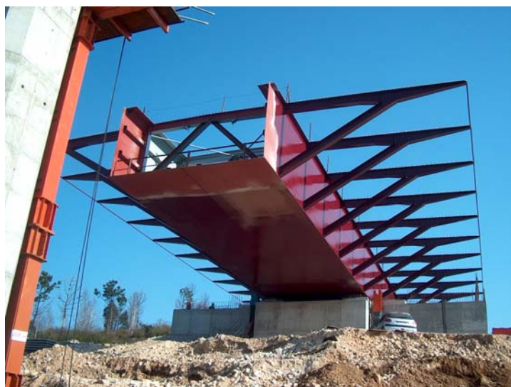
Figura 10. Lanzamiento del cajón desde el estribo E2
