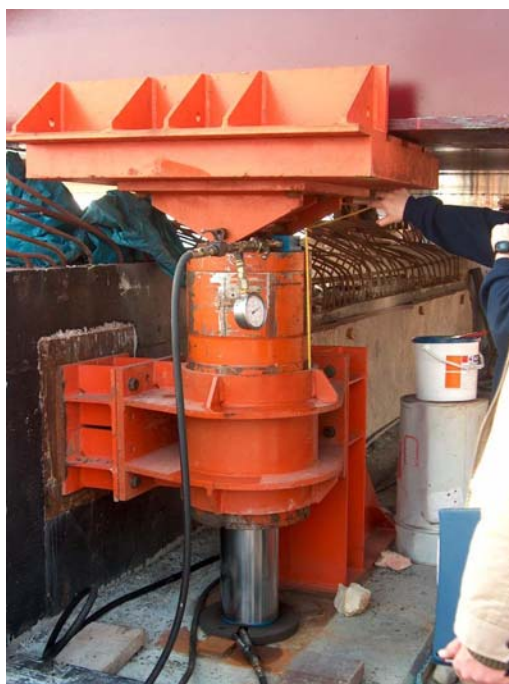
Figura 9. Apoyos de lanzamiento y gatos de regulación
