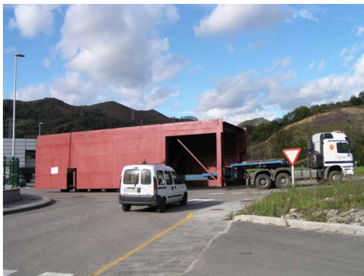
Figura 3. Transporte a obra de una semidovela
