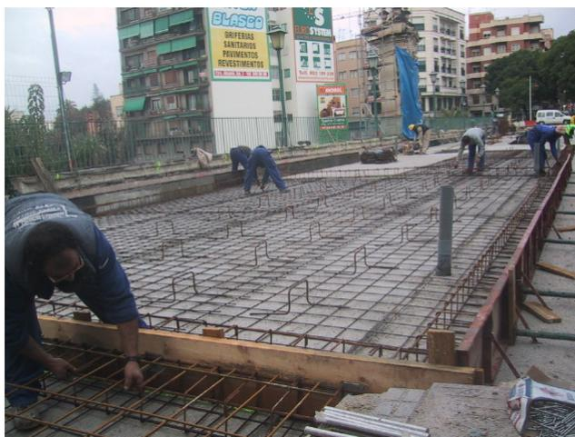
Fig. 15.- Ferrallado de la losa de firme
