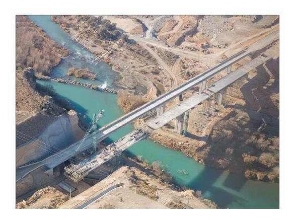
El vano 5 se construye completamente en voladizo, sin empleo de cimbra, por lo que su longitud resulta de 45 m, de lo que resulta que las reacciones verticales sobre el estribo 2 sean pequeñas. Ello obliga a la disposición de un sistema de apoyos que permita absorber las reacciones ascendentes que la torsión crea en ciertas situaciones de la sobrecarga.
