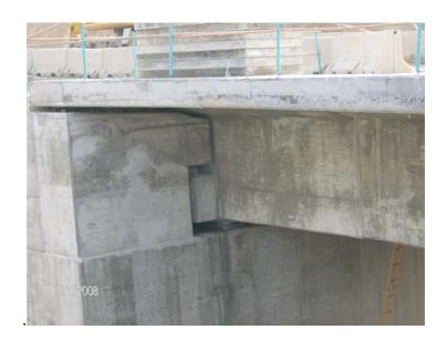
El tablero se empotra en la pila 3, que le sirve de punto fijo frente a las deformaciones horizontales, mientras que en el resto de pilas se disponen apoyos de teflón. En el caso de la pila 4 se dispone durante la construcción un bloqueo provisional capaz de absorber los desequilibrios existentes durante la construcción por voladizos sucesivos, que se retira una vez apoyado el tablero sobre el estribo 2.
