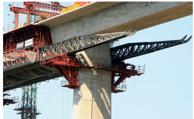
Figura 15. Apoyos de anillos en las pilas de los tramos de acceso
