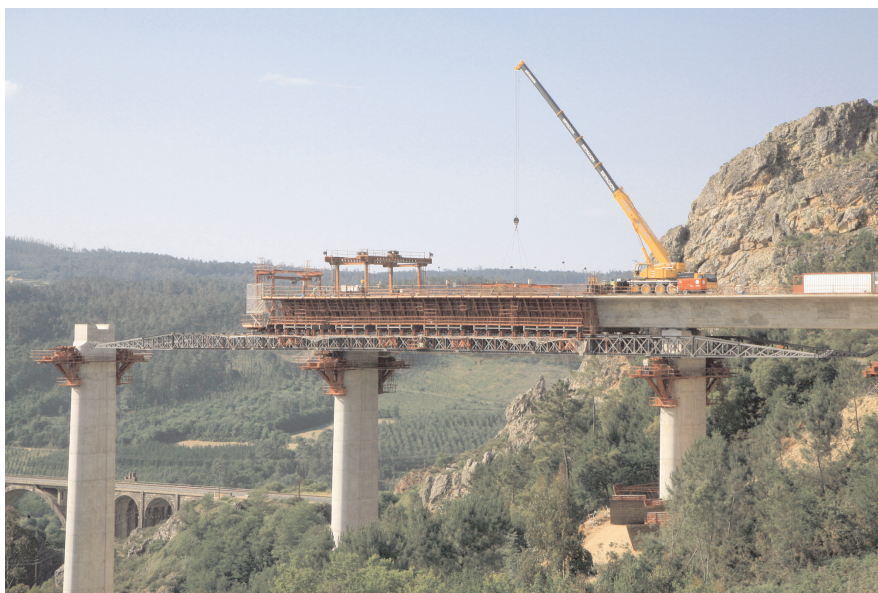
Figura 11. Ejecución del tablero con cimbra autolanzable
