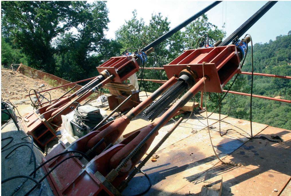
Figura 22. Estructura de transferencia en anclaje de retenida
