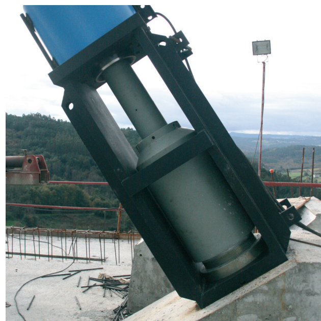
Figura 23. Gatos de tesado de tirantes con puente
