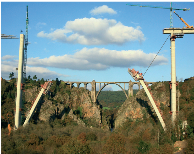
Figura 8. Alzado del arco en construcción
