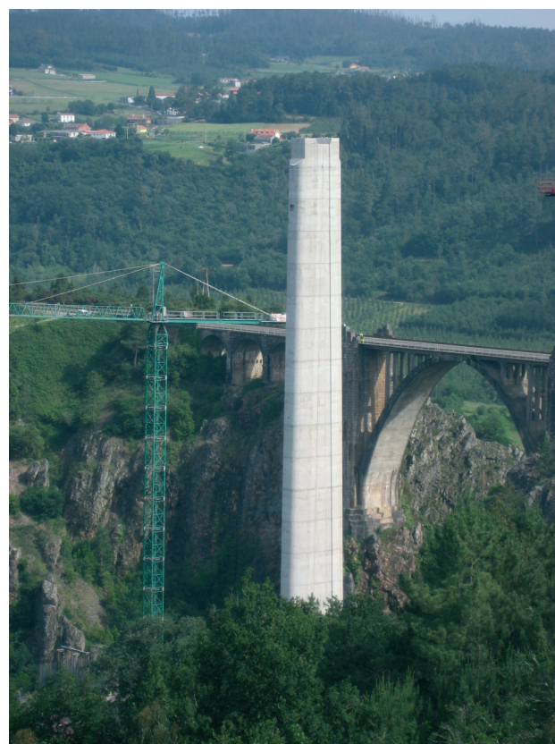
Figura 12. Fustes de pilas de tramos de acceso
