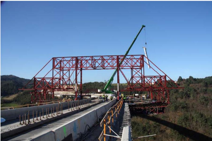
Figura 38. Carro n°3 y colocación de un nuevo jабalcón
