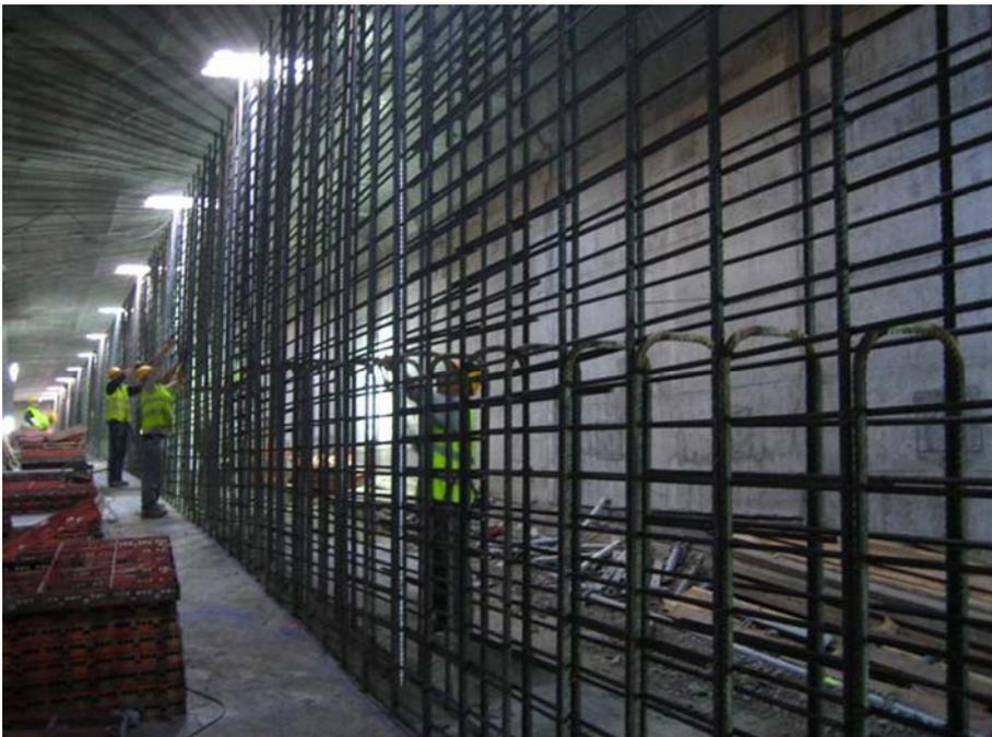
Figura 30. Ferrallado anterior al hormigonado del alma central
