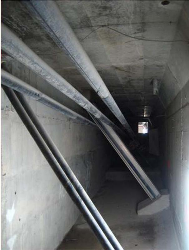
Figura 31. Pretensado longitudinal, diagonales y puntales
