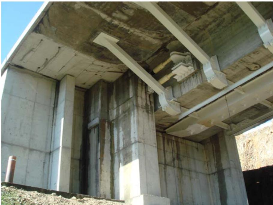
Figura 11. Vista general del estribo y dispositivos transmisores de carga
