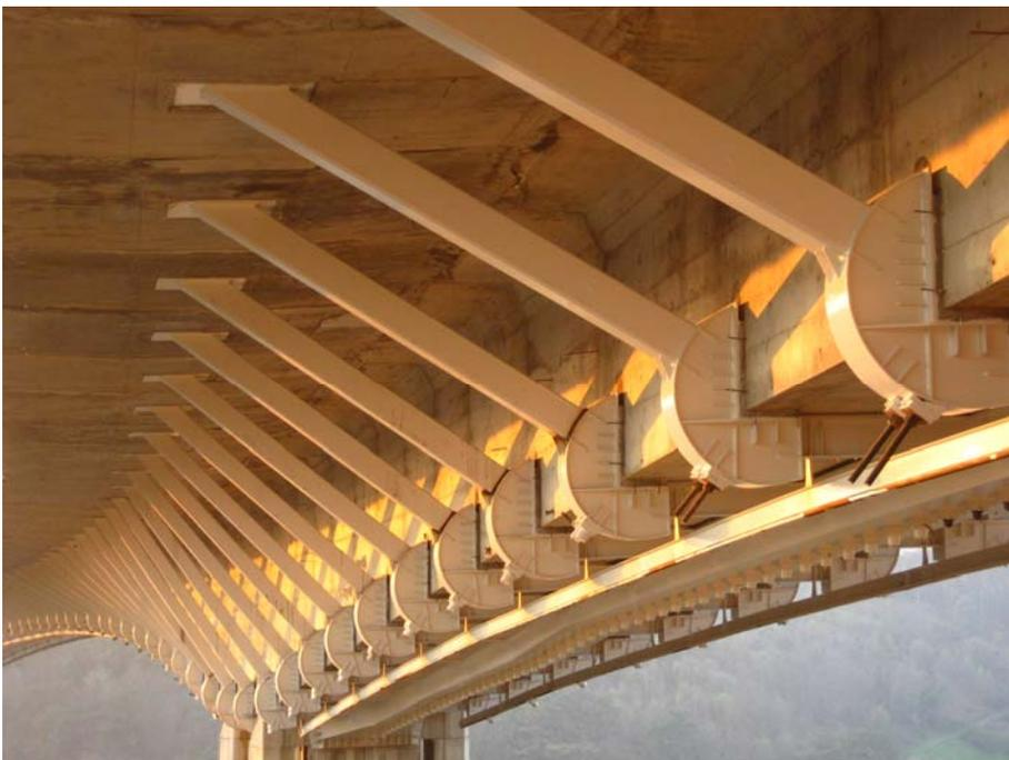
Figura 19. Jabalcones, nudos metálicos y forjados de ampliación
