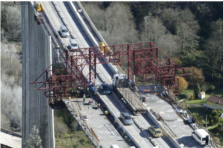
Figura 4. Tráfico por el puente existente durante el proceso de ampliación
