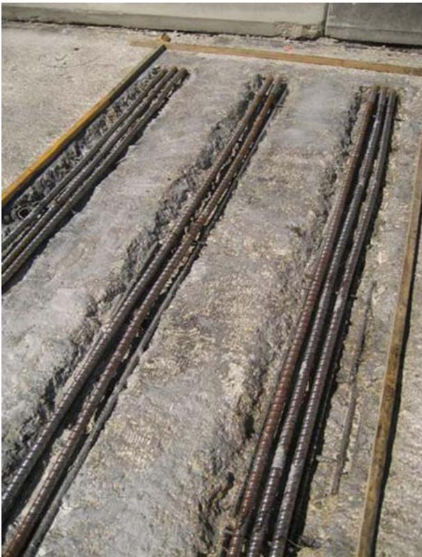
Figura 29. Disposición de monotorones en forjado superior
