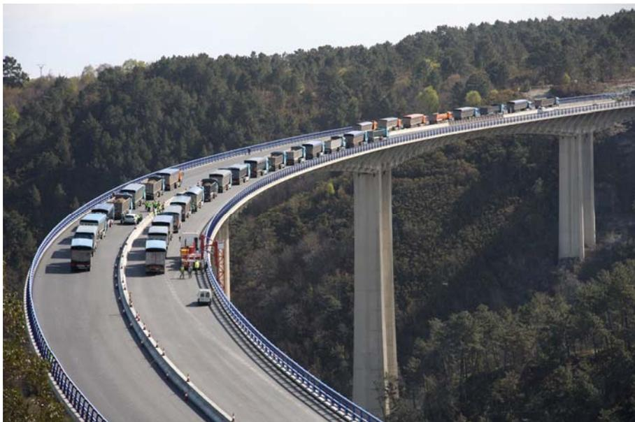
Figura 41. Realización de la prueba de carga
