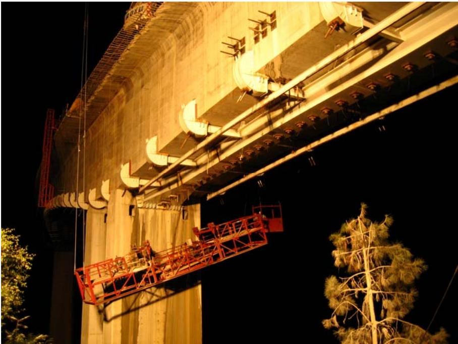
Figura 27. Montaje de carro n°2 durante
