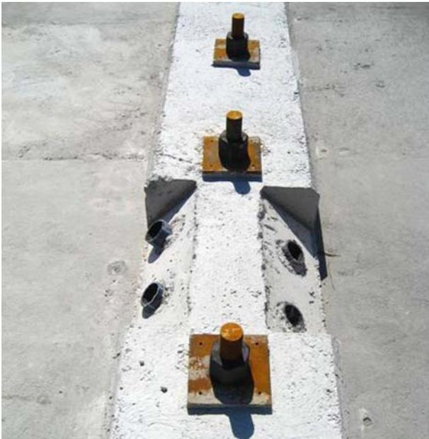
Figura 17. Tacón de anclaje de barras verticales y diagonales
