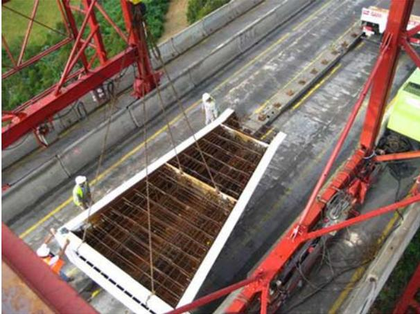
Figura 33. Colocación de un tramo de núcleo
