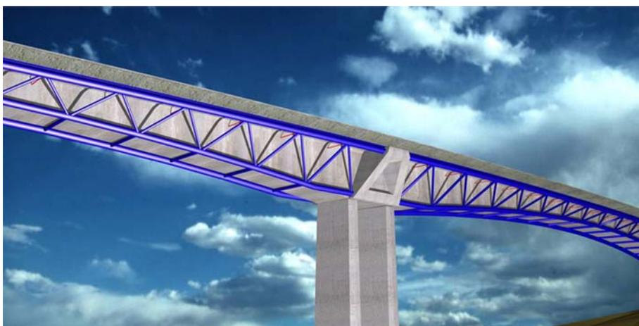
Figura 5. Solución de ampliación mediante celosías metálicas
