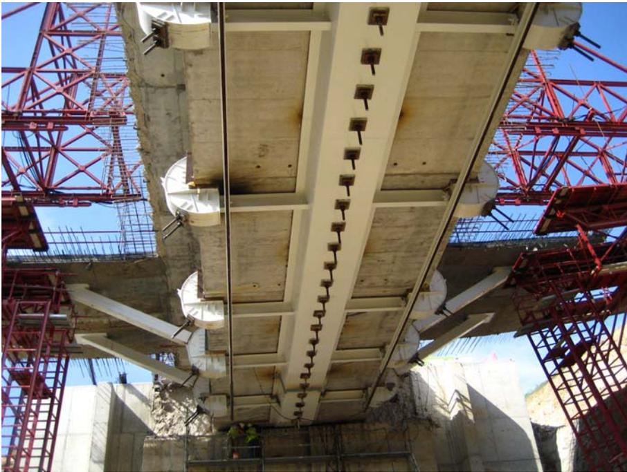
Figura 16. Refuerzo de tablero: núcleo mixto, travesaños, nudos, diagonales, jabalcones y nuevo forjado de ampliación
