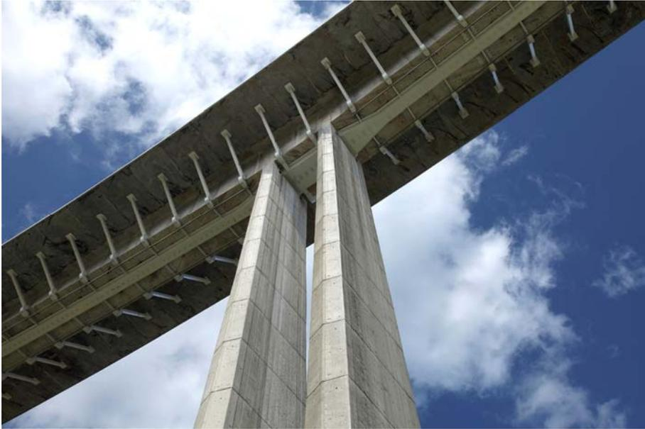
Figura 7. Solución de refuerzo de cajón existente. Vista inferior del tablero ampliado
