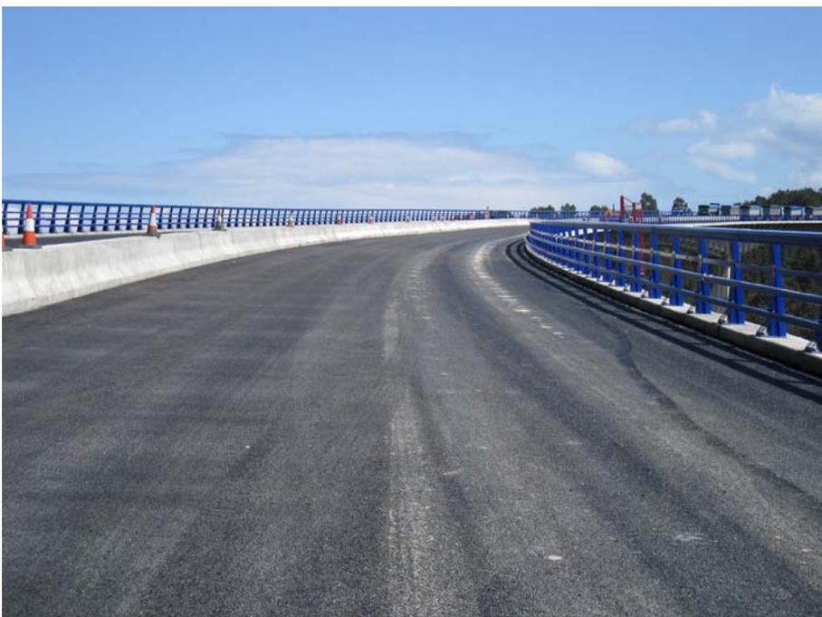
Figura 40. Realización de acabados: pretilas, barrera central y pavimentación
