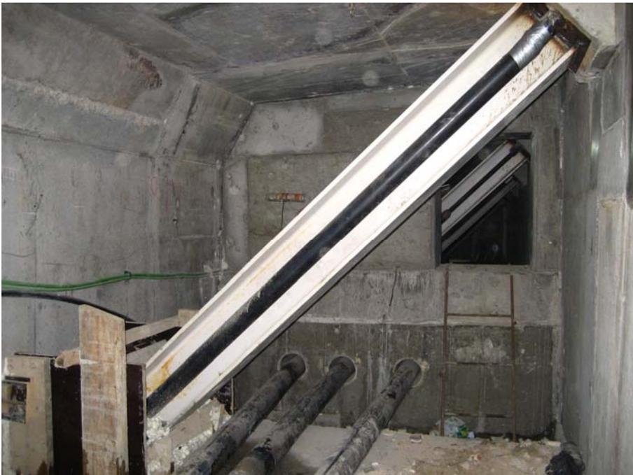
Figura 21. Puntales, diagonales y desviador en centro de vano
