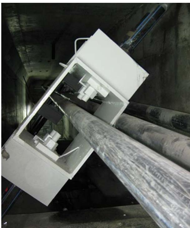
Figura 35. Puente especial para interferencias entre diagonales y pretensado exterior
