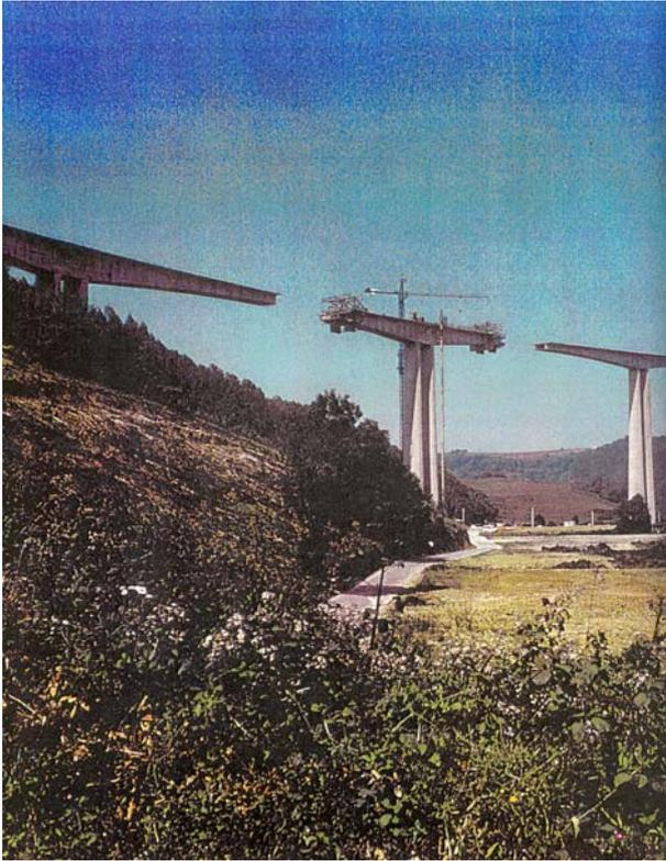
Figura 3. Construcción viaducto original
