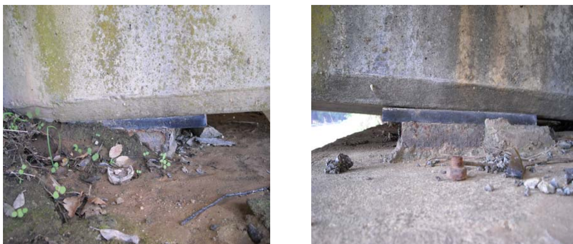
Figura 5 - Apoyos bloqueados o desplazados de su posición teórica
