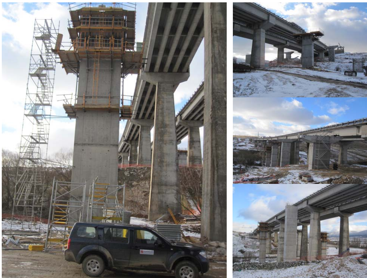
Figura 12 -Algunas vistas de las obras de rehabilitación de los viaductos de la AP-6
