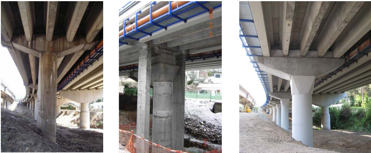
Figura 14 –Rehabilitación de pilas en un viaducto de la AP-6
