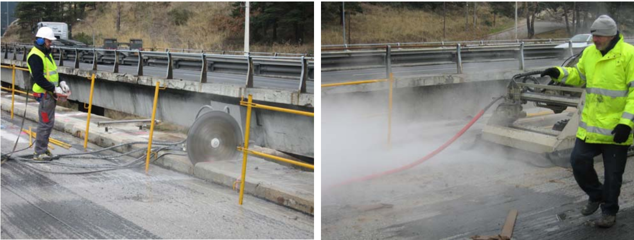
Figura 13 –Reparación de la losa forjado del tablero del Viaducto de San Rafael en la AP-6
