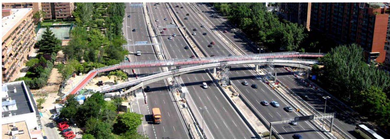
Figura 2. Apeos provisionales para apoyo del arco. Detrás, la nueva pasarela.
