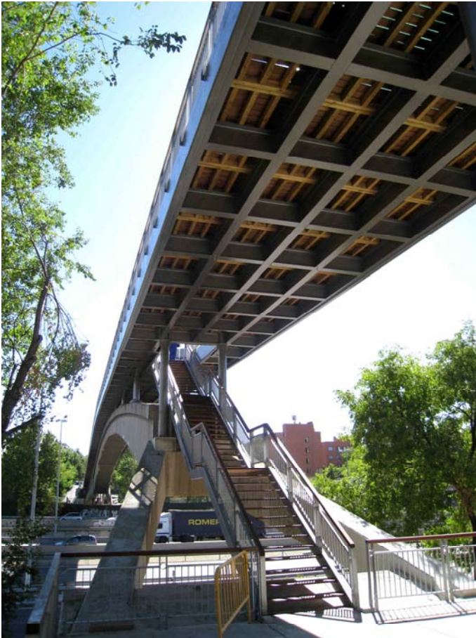
Figura 5. Vista inferior del tablero y detalle de escalera de acceso.
