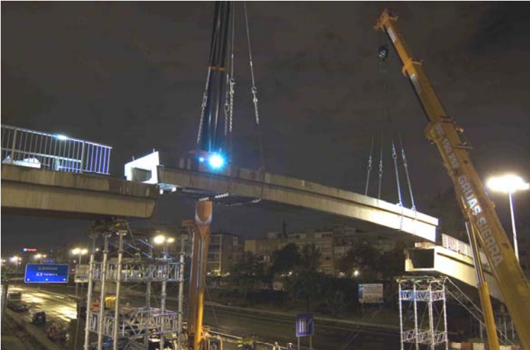
Figura 3. Retirada del primer tramo de arco con ayuda de dos grúas móviles ubicadas en la calzada cortada.
