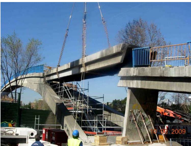
Figura 6. Retirada con grúa de un tramo previamente cortado de la rampa de acceso este.
