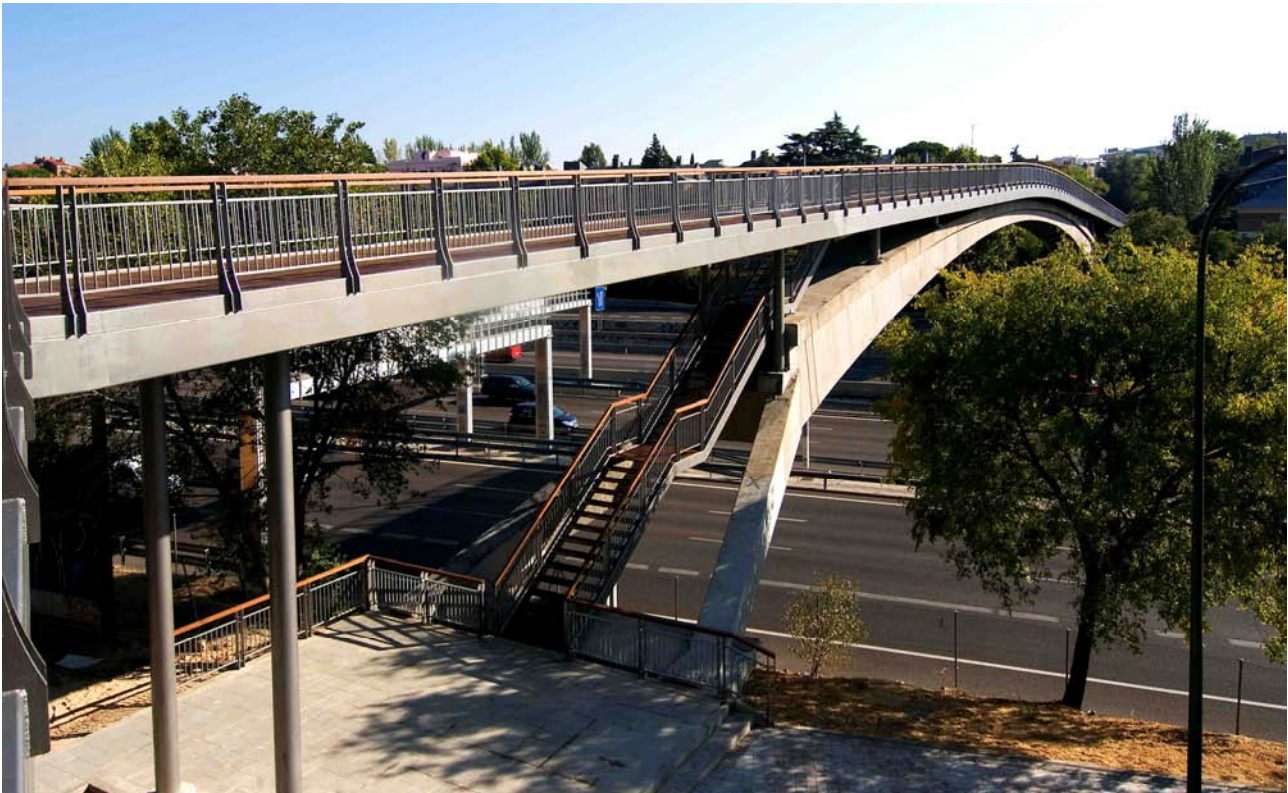
Figura 8. Pasarela finalizada y en servicio. Vista general desde tramo oblicuo. Detalle de escalera.
