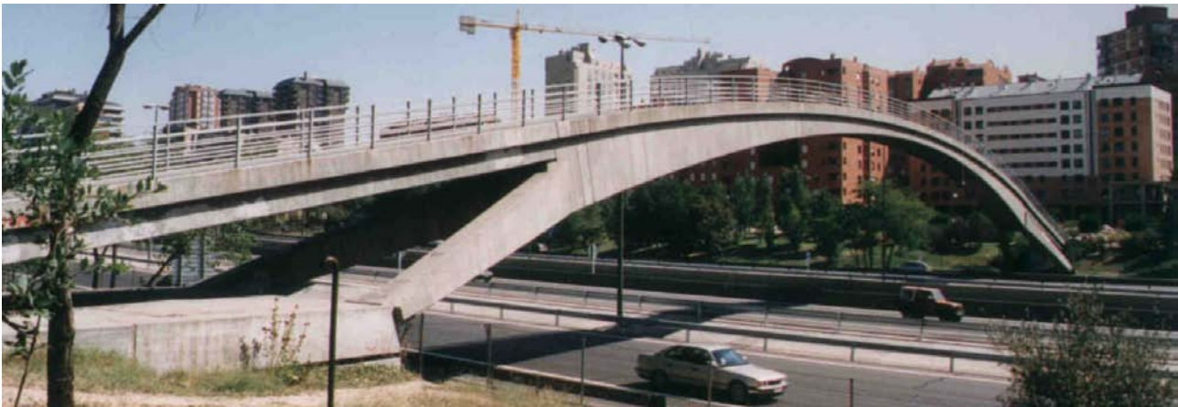
Figura 1. Vista general de la pasarela de San Juan Bautista, con el estribo móvil en primer plano.
