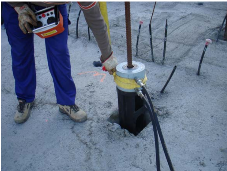
Figura 3. Tesado del pretensado vertical por almas
