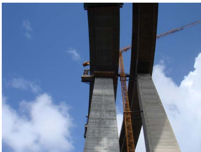
Figura 6. Vista inferior de la curvatura del tablero
