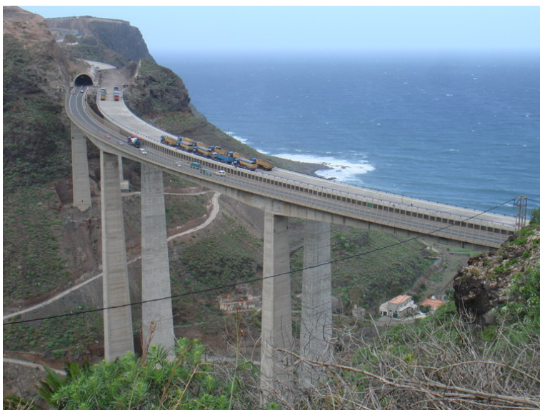
Figura 6. Vista durante la realización de la prueba de carga estática.
