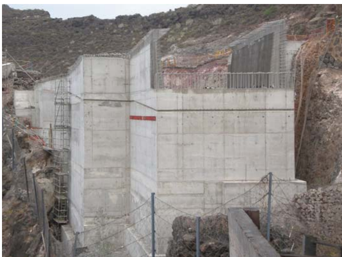
Figura 4. Vista frontal del estribo 2 en ejecución.
