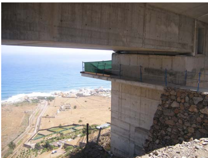
Figura 5. Detalle de la pasarela peatonal en muro de frente del estribo 2
