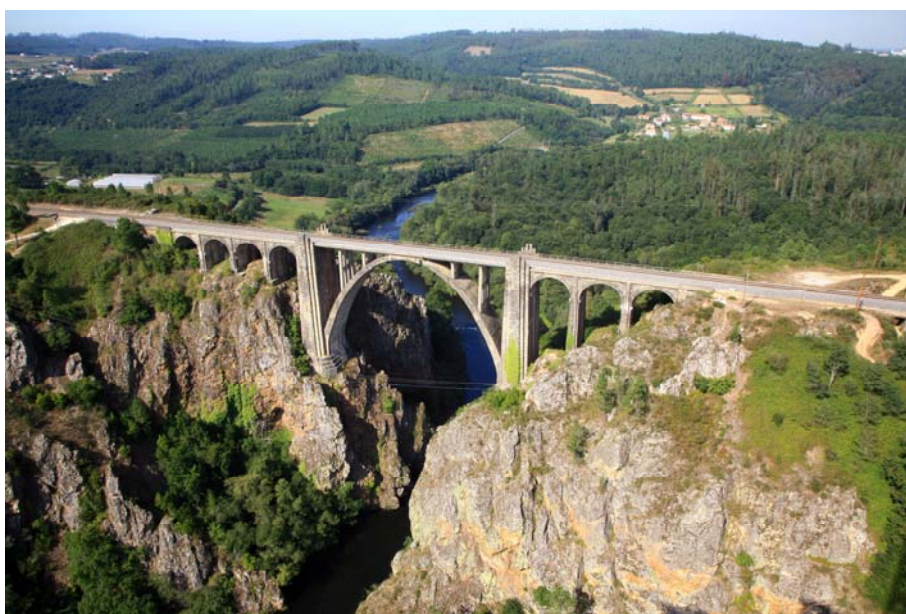
Figura 4. Viaducto de Gundián sobre el río Ulla.
