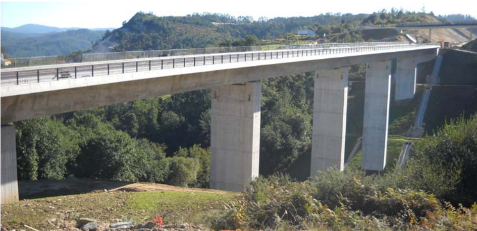
Figura 2. Viaducto de Castro.
