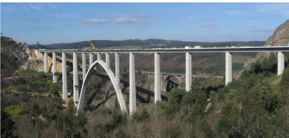
Figura 3. Viaducto sobre el río Ulla.
