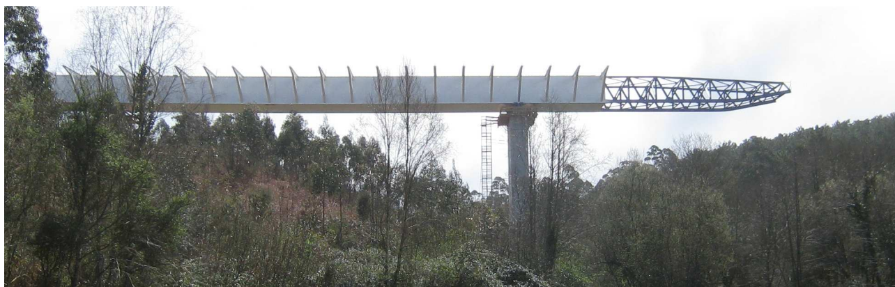
Figura 1: Alzado del puente durante su lanzamiento.
