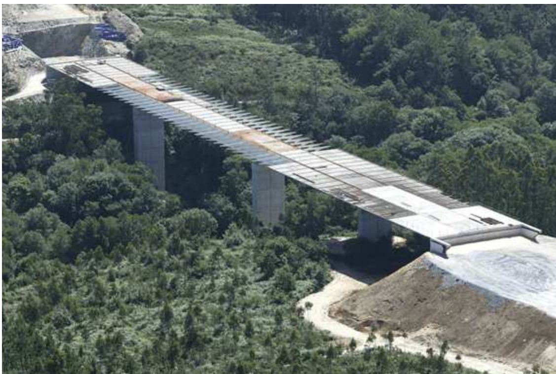
Figura 5. Proceso constructivo de las partes de hormigón del tablero.
