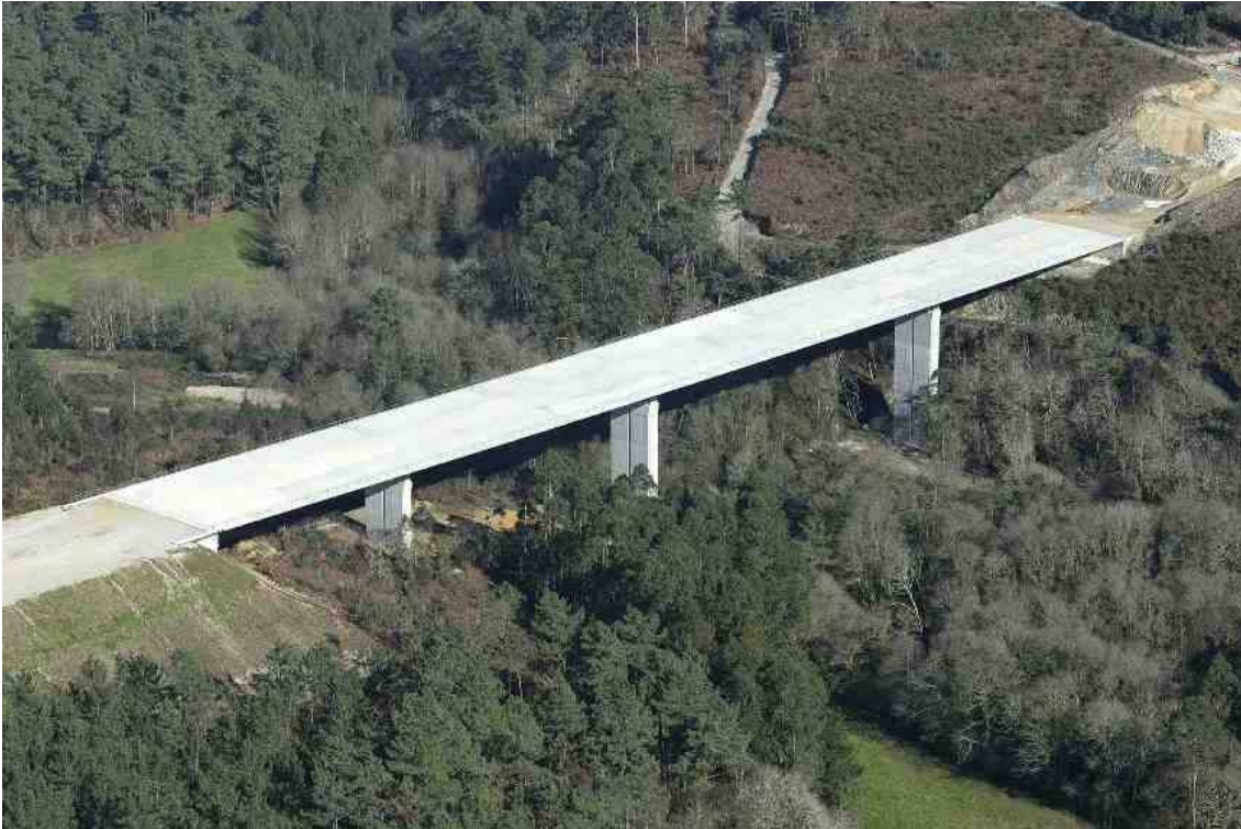
Figura 6. Vista aérea del puente con el tablero terminado.
