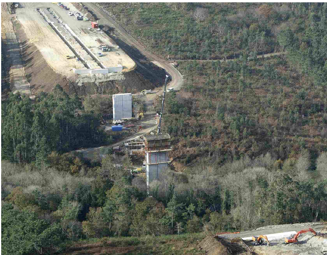
Figura 4. Vista aérea durante la construcción de la subestructura. Parque de fabricación tras E-1.
