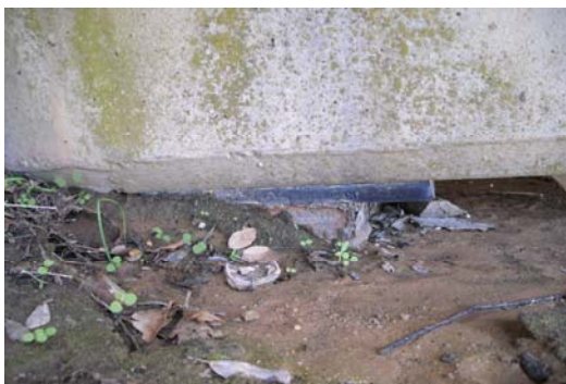
Figura 4. Apoyos bloqueados y desplazados de su posición teórica
