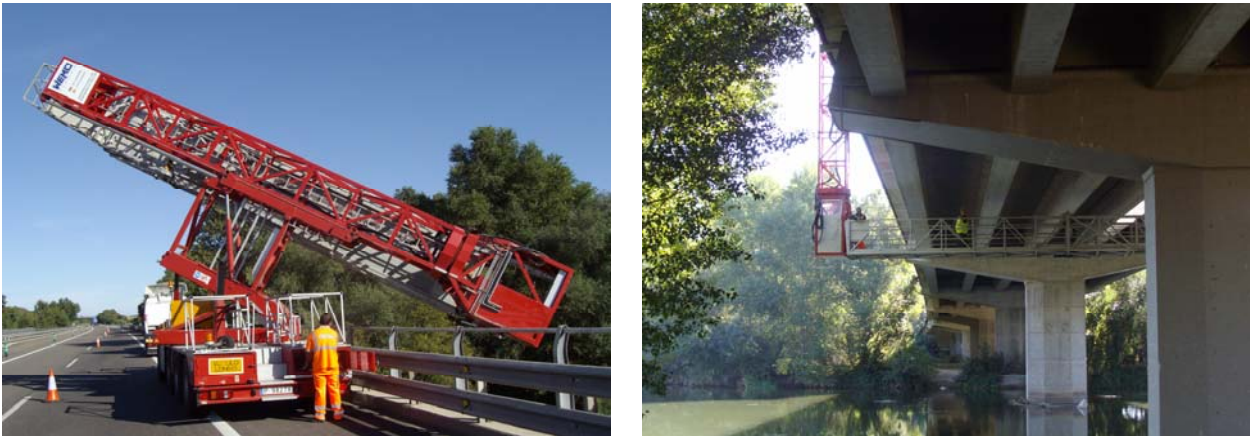
Figura 7. Vistas de la pasarela autoportante utilizada en buena parte de las inspecciones
