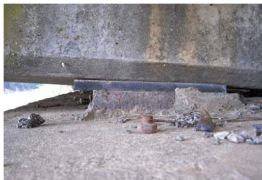
Figura 4. Apoyos bloqueados y desplazados de su posición teórica
