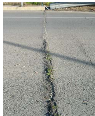
Figura 5. Junta de calzada deteriorada o inexistencia de junta de calzada
