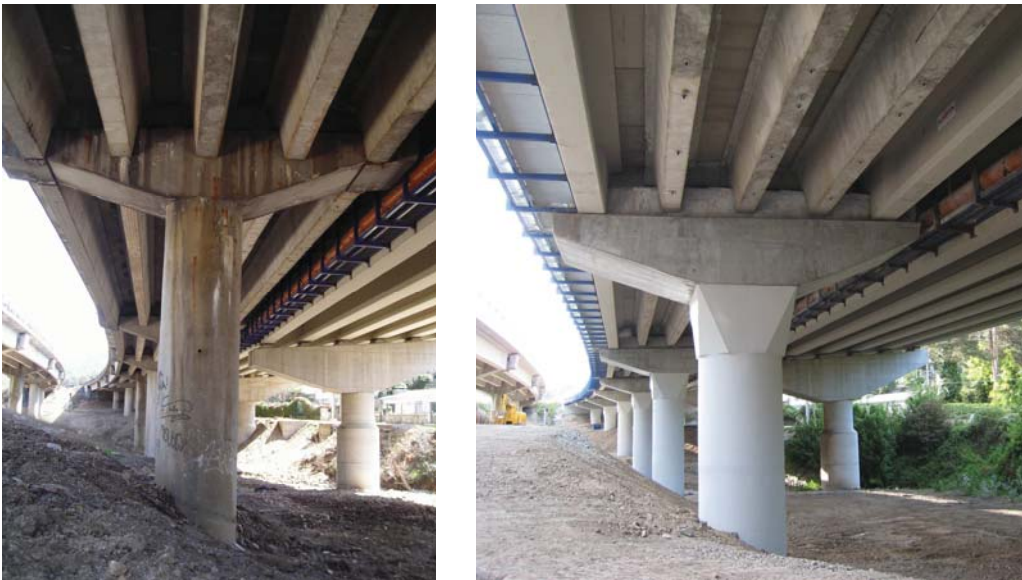
Figura 7. Vista de Viaducto de San Rafael. Actual calzada reversible. Antes y después de la actuación
