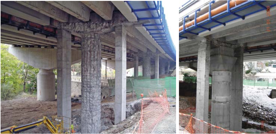
Figura 6. Fase de obras de refuerzo de pilas de los viaductos de San Rafael
