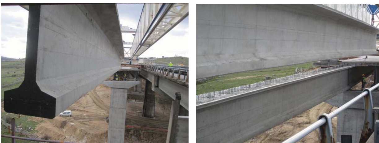
Figura 10. Montaje de vigas en el viaducto de Arenales, calzada sentido Madrid.
