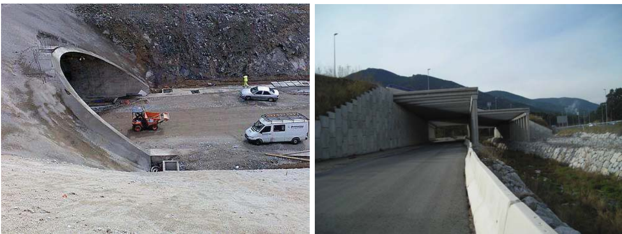
Figura 3. Obras en la boquilla sur del túnel 3 y pérgola sobre el río Gudillos
