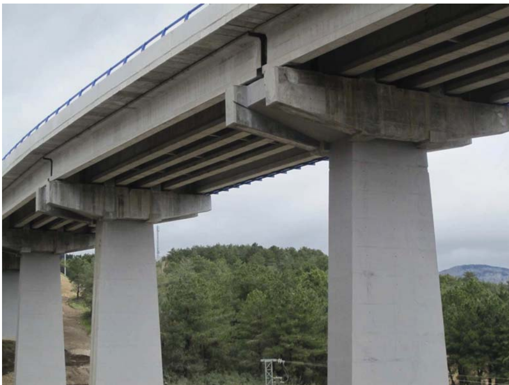
Figura 5. Viaducto de La Jarosa. Calzada sentido La Coruña
