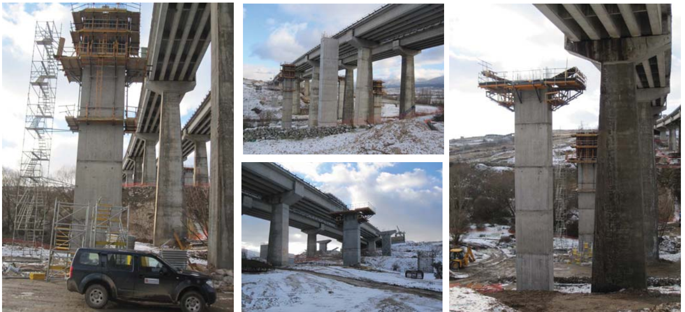
Figura 8. Algunas instantáneas de la construcción de los nuevos viaductos de Arenales
