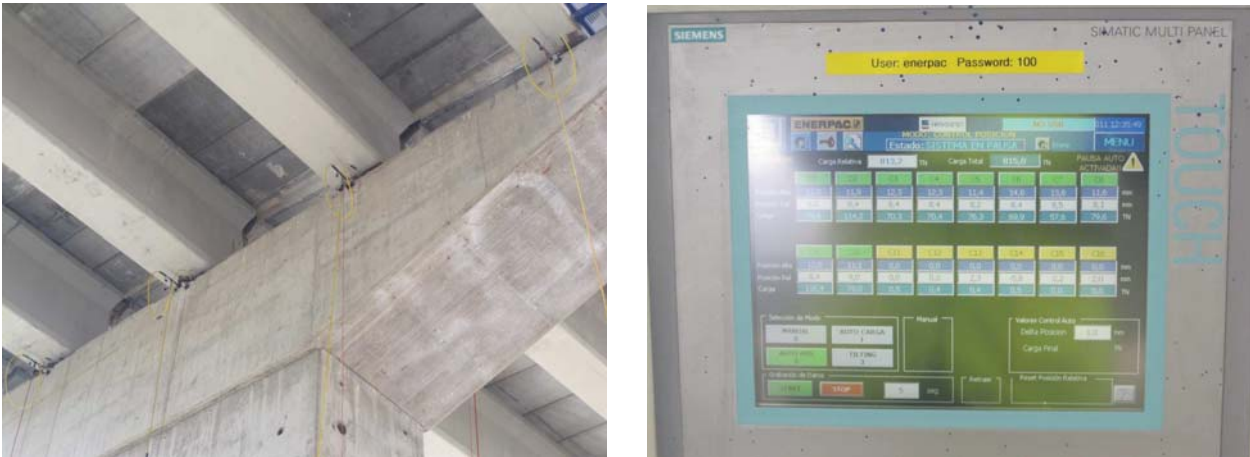
Figura 4. Durante el izado de los apoyos de la pila 2 y pantalla de CPD
