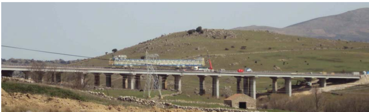
Figura 9. Vista general del viaducto de Arenales, con la viga de lanzamiento, calzada sentido Madrid.
