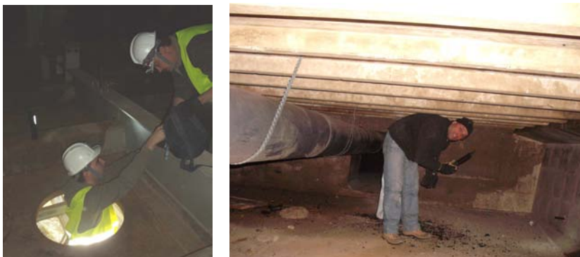
Figura 6. Imágenes durante las inspecciones interiores de tableros
