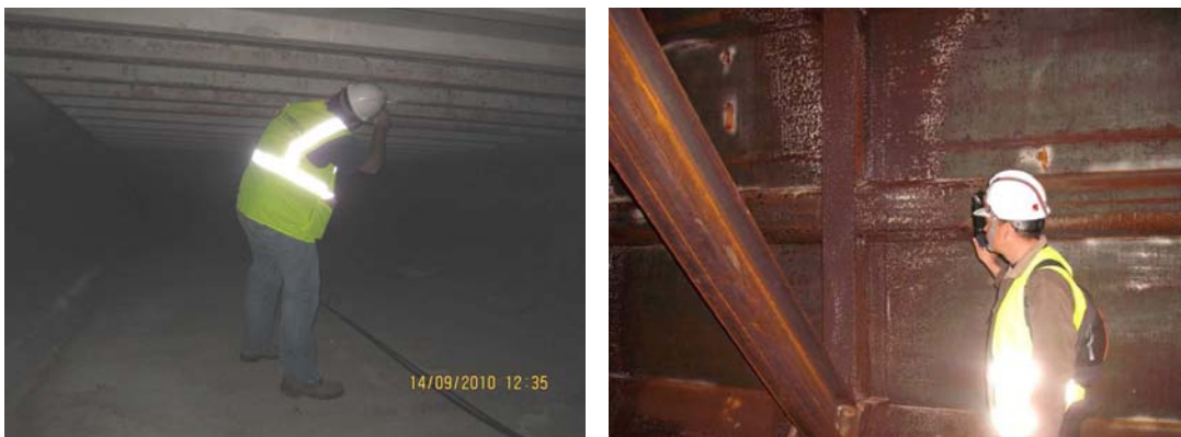
Figura 2. Imágenes durante las inspecciones interiores de tableros
