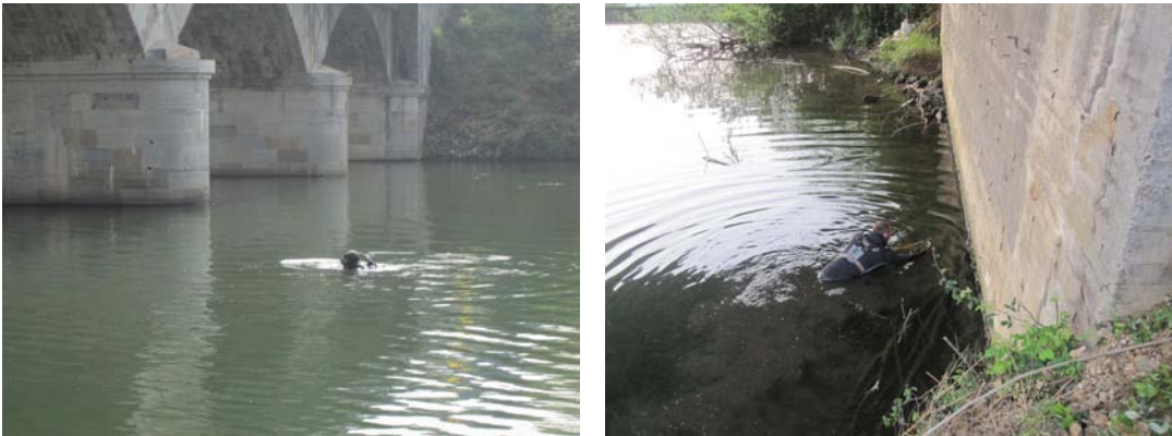
Figura 3. Imágenes durante las inspecciones subacuáticas de cimentaciones
