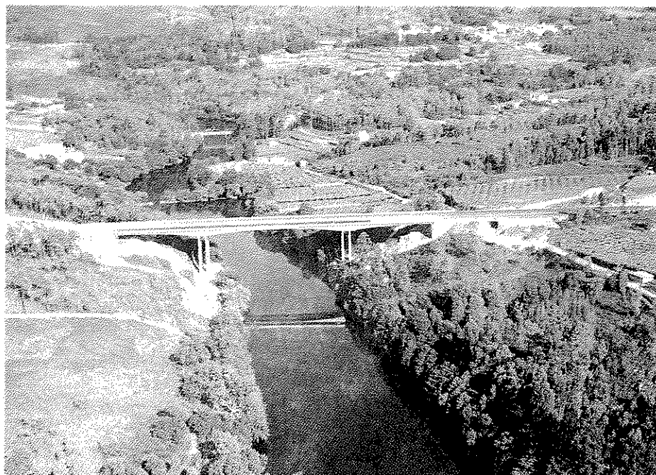
Fig. 5. Vista aérea del puente terminado.
